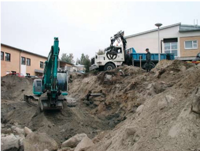
Pilaantuneen maaperän puhdistusta Iломantsissa. Kuva Jari Tiainen.
