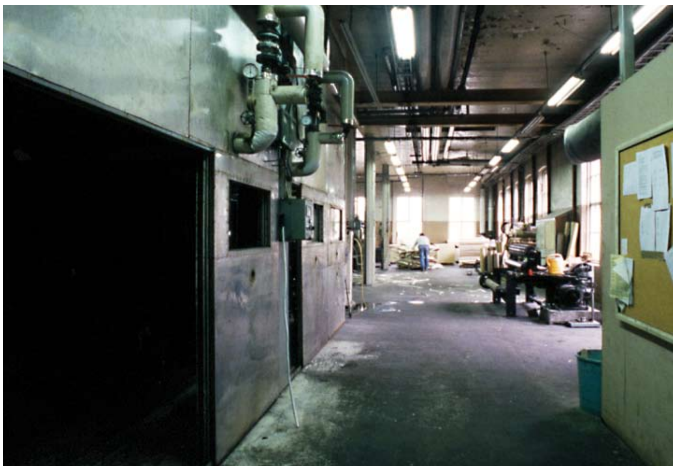
Kuva 25: Kartonkikalialia. Vasemmalla kuivaussyylinterinosaan teräslevyillä päällystettyä seinäkettä. Oikealla näkyy osa taukokuoneen seinästä. Matti Huuhka 1998, Museokuva, MV.
