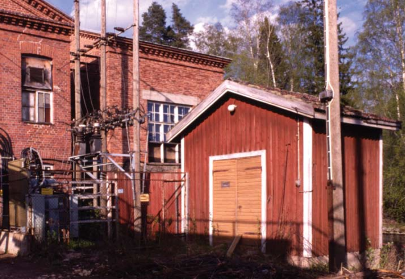
Kuva 44: Kartonkitehtaan vieressä oleva muuntajahuone kuvassa oikealla. Matti Huuhka 1998, Museokuva, MV.
