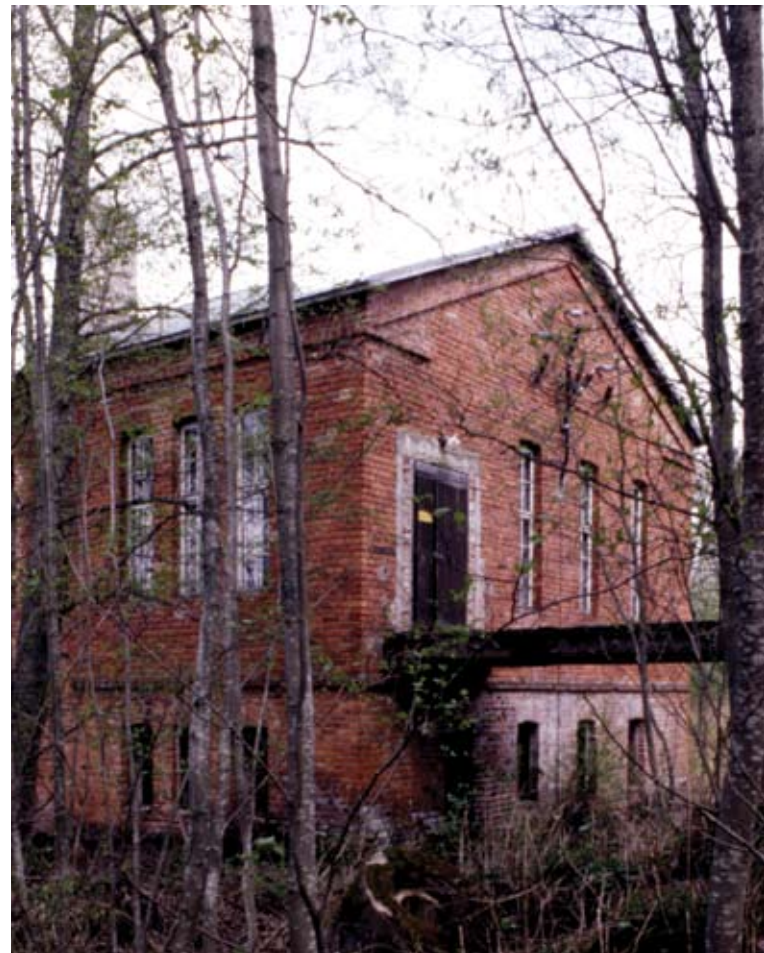
Kuva 29: Alatehdas etelästä. Kuvassa oikealla sisäänkäynti ja puinen kulkusilta. Matti Huuhka 1998, Museokuva, MV.
