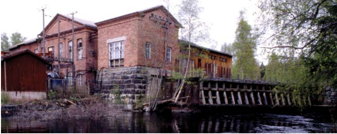
Kuva 16: Kartonkitehtaan hiomo, voimalaitos ja turbiinisuoja. Kuvassa oikealla voimakanava ja vasemmalla muuntajahuone. Matti Huuhka 1998, Museokuva, MV.
