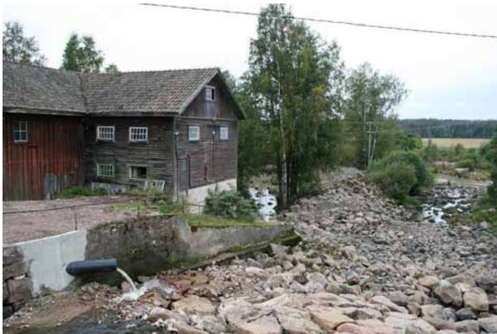
Kuva 14. Kuuskosken vanha voimalaitos on vanhan saharakennuksen yhteydessä. Rakennuksen takana näkyvä sivu-uoma kunnostettiin lohikalojen kutu- ja poikastuotantoalueeksi. Kuva on otettu 9.9.2008, jolloin vesityspotkusta virtasi vettä vain noin 50 l/s, koska virtausta rajoitettiin kalatien yläkynnyksen ollessa kesken.
