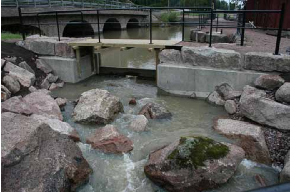
Kuva 16. Kuuskosken kalatien yläkynnys vielä keskeneräisenä 9.9.2008. Betonisen yläkynnyksen päälle on asetettu settilankkuja, joilla rajoitetaan kalatien virtausta.
