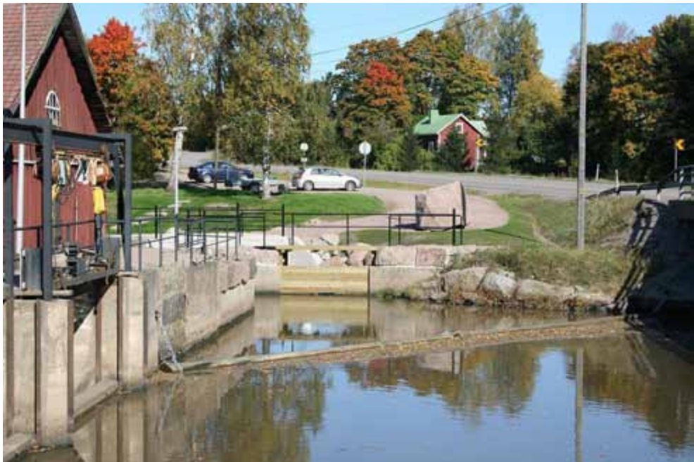
Kuva 17. Kalatien yläkynnyksen eteen asennetulla puomilla ohjataan puiden lehdet ja oksat ym. patoaukkoon. Yläkynnyksessä oli 24.9.2008 vielä settilankut paikoillaan, koska kynnyks ei ollut valmis.
