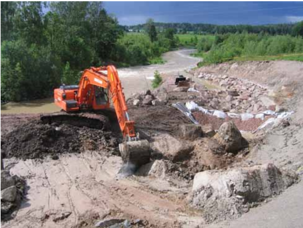
Kuva 3. Kuuskosken kalatien rakentamisen eri vaiheita oli näkyvillä 26.6.2008. Viimeistelyä vaille valmis alin osuus oli peittynyt veden alle joen vedenpinnan noustua sateiden jälkeen, yksi kynnyks oli rakenteilla ja sen yläpuolelta kaivettiin maita pois. Kaivumaiden seassa oli isoja lohkaraita.
