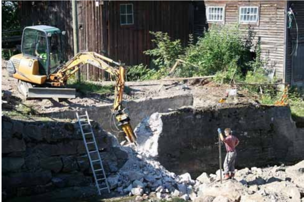
Kuva 9. Kosken reunamuuriin tehdään vesityspotken läpivientä 23.7.2008.
