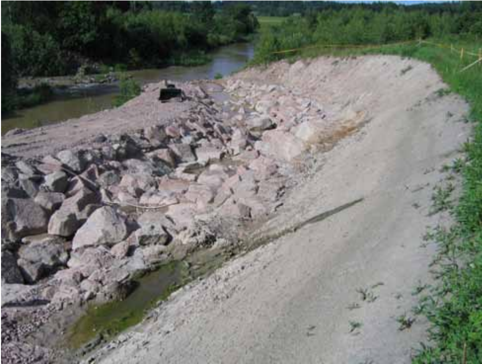
Kuva 5. Kalatien lähellä sijaitsevan asuinrakennuksen jätevesijärjestelmään kuuluvan sakokaivon purkuputkesta valuvan pienen vesimäärän jäljiltä kalatien luiskassa oli 8.7.2008 vihreä vana ja kalatiessä pieni lammikko.
