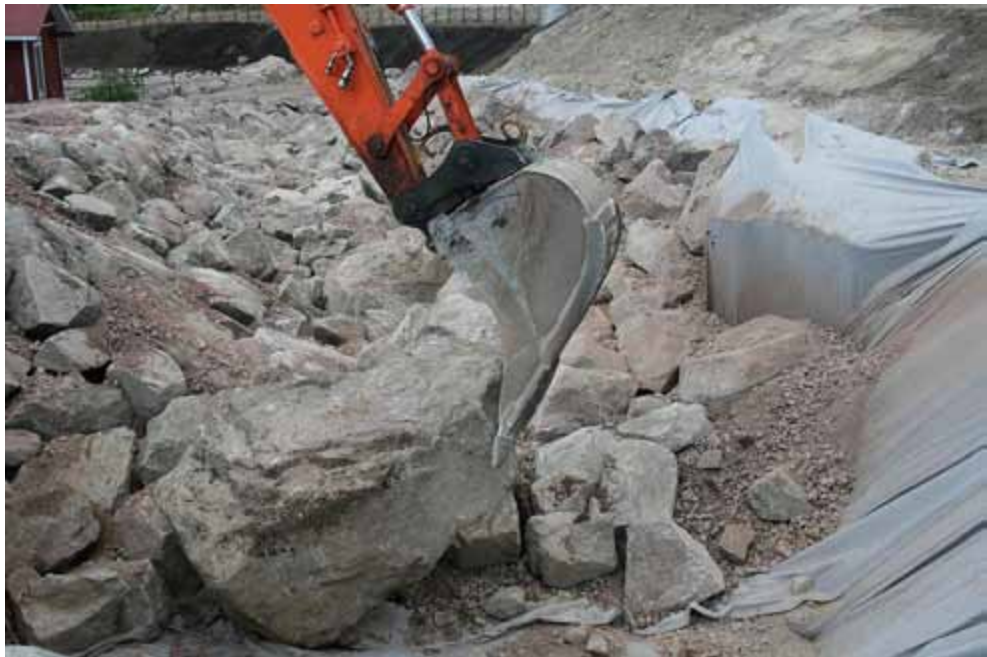
Kuva 10. Kivien asettelua kalatien yläosassa 29.7.2008.
