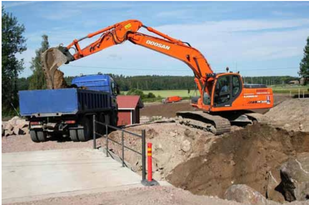
Kuva 7. Kalatien yläosan kaivumaita kuormataan poisvietäväksi 23.7.2008. Sillan kaide on jo paikallaan.
