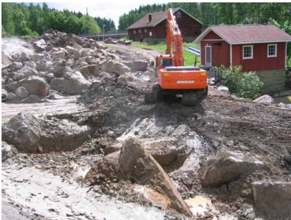
Kuva 4. Kalatieuomaa kaivettaessa esille tulleita isoja lohkareita jouduttiin räjäyttämään pienemmäksi. Lohkareiden yläpuolelle on varastoitu kiviä myöhempää käyttöä varten. Kaivinkoneen vieressä voimalaitoksen koneasema. Taustalla vanha myllyrakennus.
