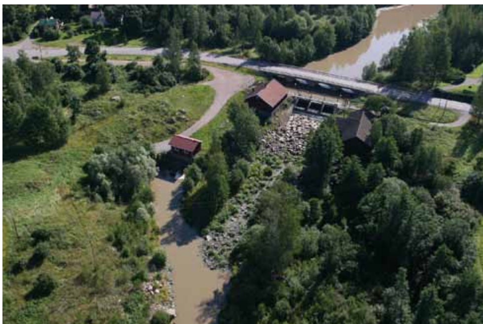
Kuva 1. Koskenkylänjoen Kuuskoski ennen kalatien rakentamista vuonna 2007. Uuden voimalaitoksen koneasema on kuvassa alinna oleva pieni rakennus. Säännöstelypadon alapuolinen koski on säännöstelyn takia vähävetinen. Kuuskosken vanha voimalaitos on kuvassa oikealla olevan vanhan saharakennuksen yhteydessä.
