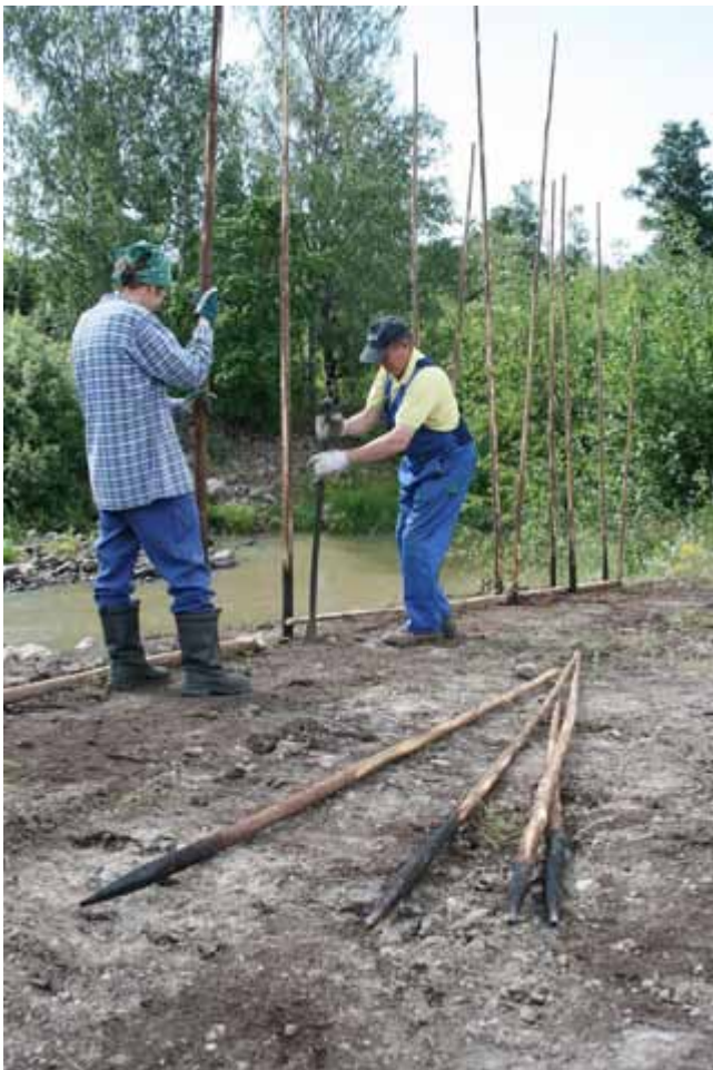
Kuva 8. Riukuaidan tekoa Kuuskosken kalatien äyräälle 23.7.2008.
