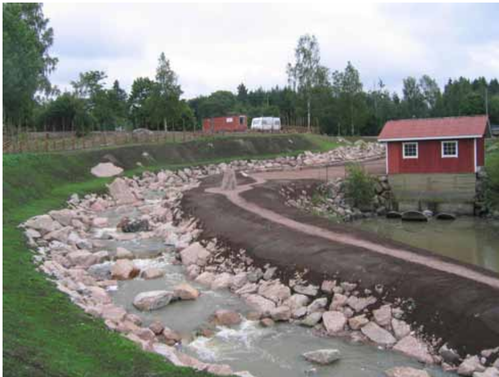
Kuva 13. Kuuskosken kalatie 21.8.2008. Kalatien kynnykset ja virtakiveykset ovat valmiit ja viimeistelyt lopuillaan.
