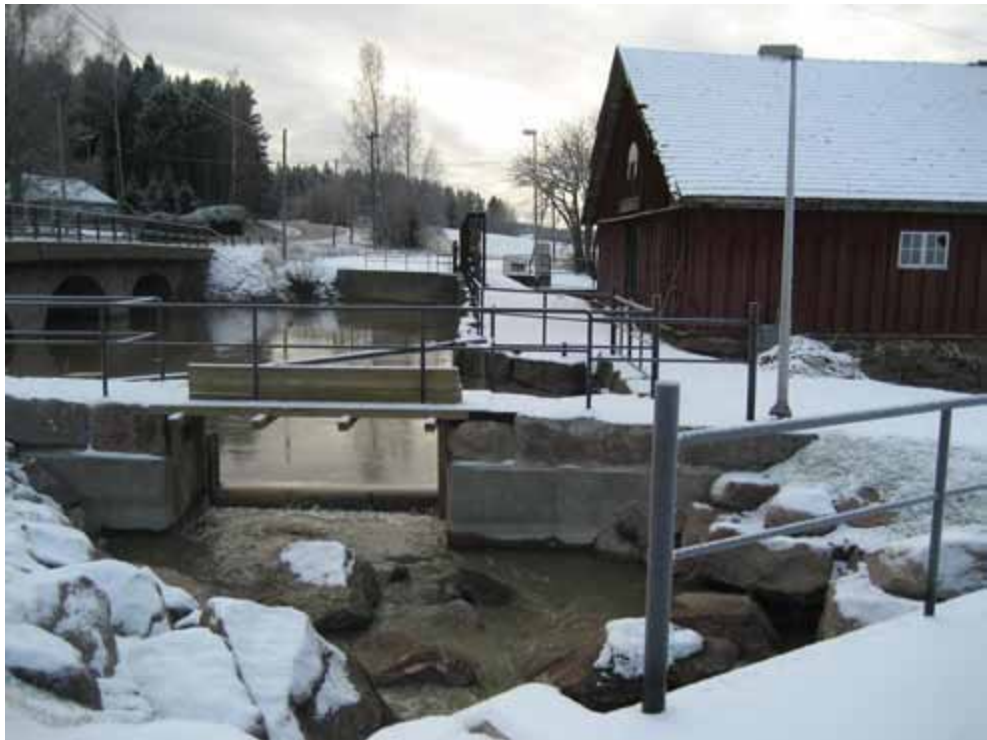
Kuva 19. Kuuskosken kalatien yläosa 21.11.2008. Kalatien yläkynnys oli valmistunut 8.10.2008. Settilankut on nostettu kalatien hoitosillalle.
