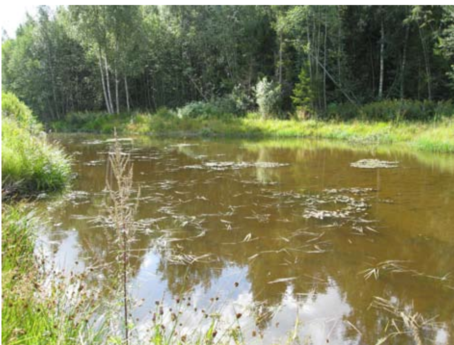
Kuvat 9, 10 ja 11. Vuoretaan peltoaukealle JÄRKI-hankkeessa rakennetut kolme laskeutusallas-kosteikkoa tasaavat Myllyojan virtaamia. Kuvat: Hanna Eskola.
