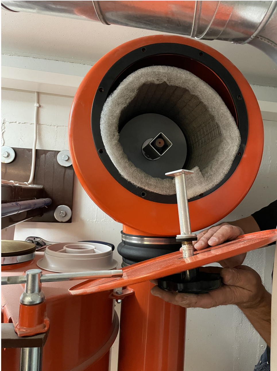
Kuva 6. Ilmanvaihtolaitteen paineventtiin esisuodattimen kunnon tarkastaminen. (Kuva: Sisäministeriö)
