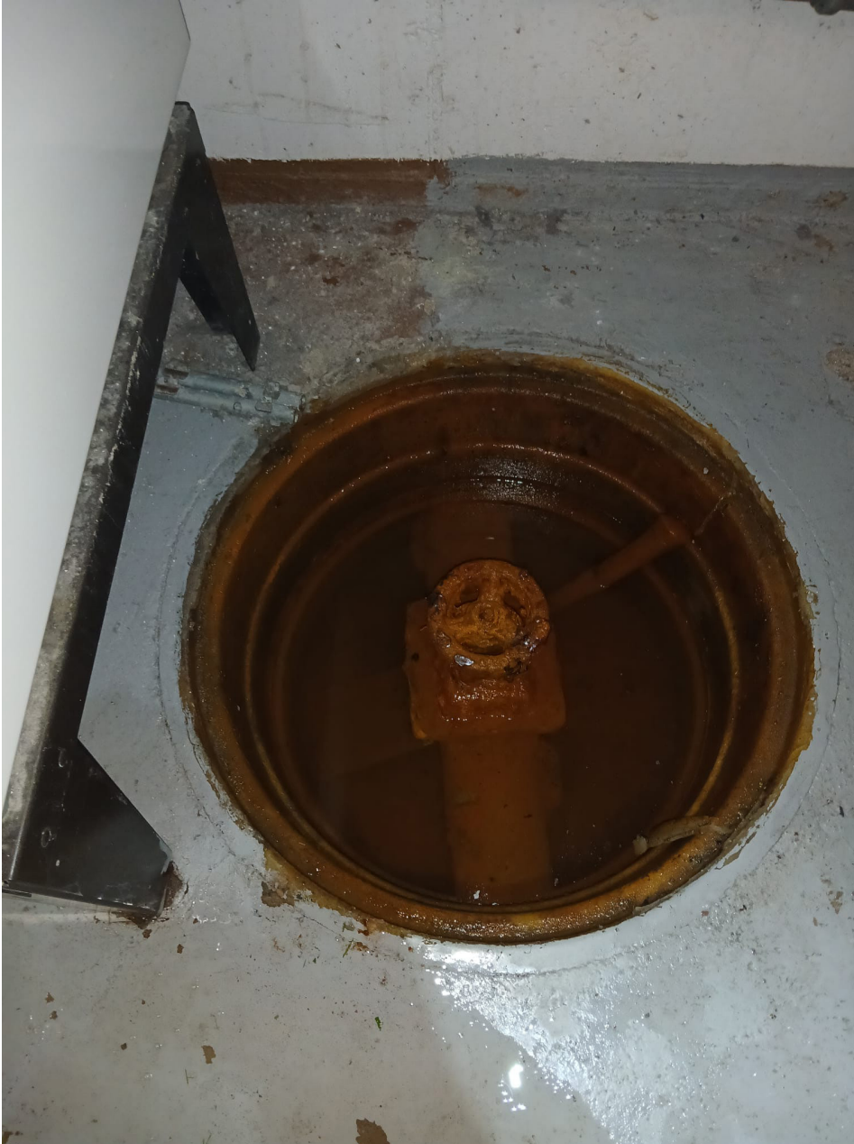
Kuva 9. Viemärikaivoon voi kertyä vettä, joka on poistettava. (Kuva: Martin Mitikka)
