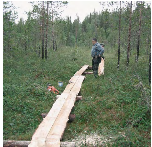
Kuva 19. Pitkosten rakentamista Kittilän Tepastossa. Kuva Mirka Hatanpää.
