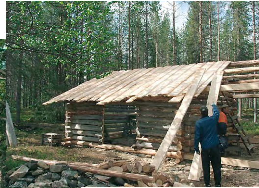
Kuva 26. Katon entisöinti tuppeen sahatuista laudoista. Kuva Timo Piirilä.
