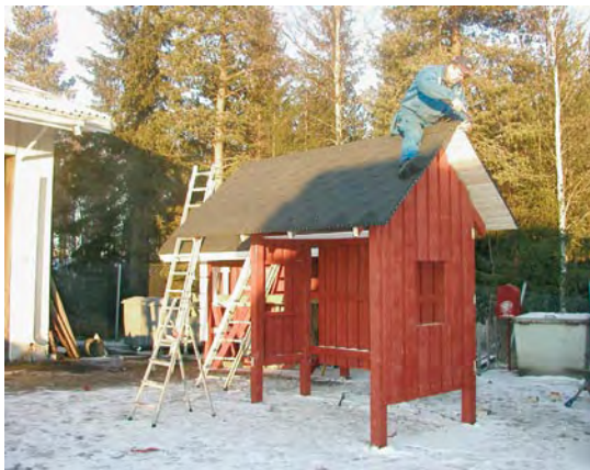
Kuva 6. Pysäkkikatoksen rakentamista Ylitorniolla. Kuva Heikki Oja.
